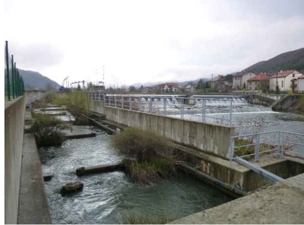
objekt MVE Šalková s rybovodom
