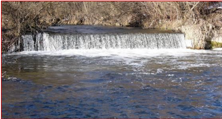
Obr. 41 Pôvodná nepriechodná migračná bariéra Muránka I pred spriechodnením – vodopádový riečny stupeň s prevýšením hladín 1 m.
