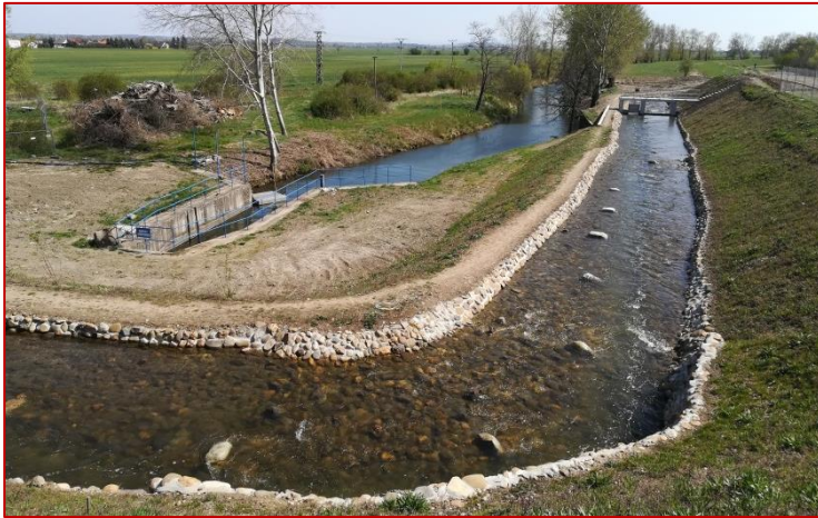
Obr. 95 Pohľad na veľmi pokojný prúd biokoridoru v celom mimohrádzovom úseku (veľmi mierny sklon len 1:200). Hĺbočina lemovaná oddychovými balvanmi prechádza striedavo od brehu k brehu.
