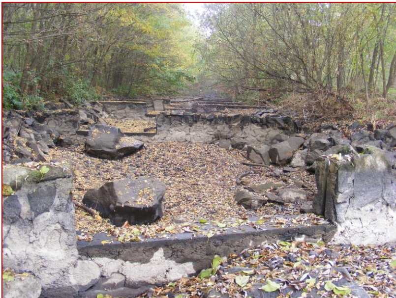
Obr. 120 Stav bez vody po rokoch. Je vidieť výrazné široké medzery v prepážkach a balvanité vybavenie bazénov. Okolo prirodzený les.
