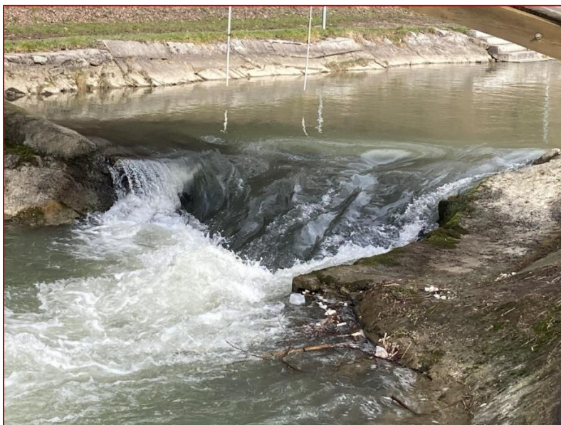
Obr. 90 Časť trasy biokoridoru upravenej pre vodákov, viditeľne nepriechodná pre ryby foto M. Kubala).
