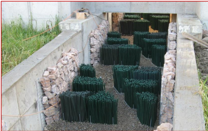
Obr. 148 Šikmé rozmiestnenie štrbín vo viacrádových prepážkach umožňuje dosiahnuť menšiu rýchlosť v štrbine, ale predlžuje dĺžku komplikovaného úseku. (foto M. Macková)
