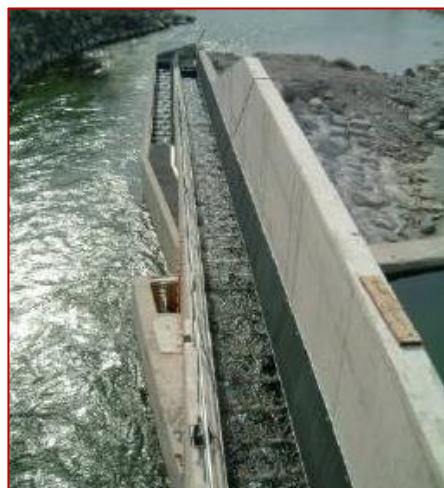
Obr. 152 a vľavo a Obr. 152 b vpravo Vodná elektrárň Au-Schönenberg na rieke Thur (Švajčiarsko), pilotný projekt s realizovaným štetinovým rybovodom (2003). Poučné je „poschodové“ technické vyriešenie rybovodu – jeho protismerné zalomenie kvôli tomu, aby výtok z neho (vstup pre ryby) nebol mnoho desiatok metrov ďaleko od bariéry, ale len niekoľko metrov pod migračnou bariérou, v hlavnom navádzacom prietoku pod výtokom z turbín. Výhodnejšie umiestnenie vstupu pre ryby a miernejší sklon rybovodu sú pre ryby dôležitejšie ako neprirodzené pôsobiace zvislé betónové brehy a technicky zložité riešenie, aj ako čiastočné lokálne prekrytie časti trasy. (Úsek s úplnou tmou by však bol nevhodný pre denné migrácie rýb).
