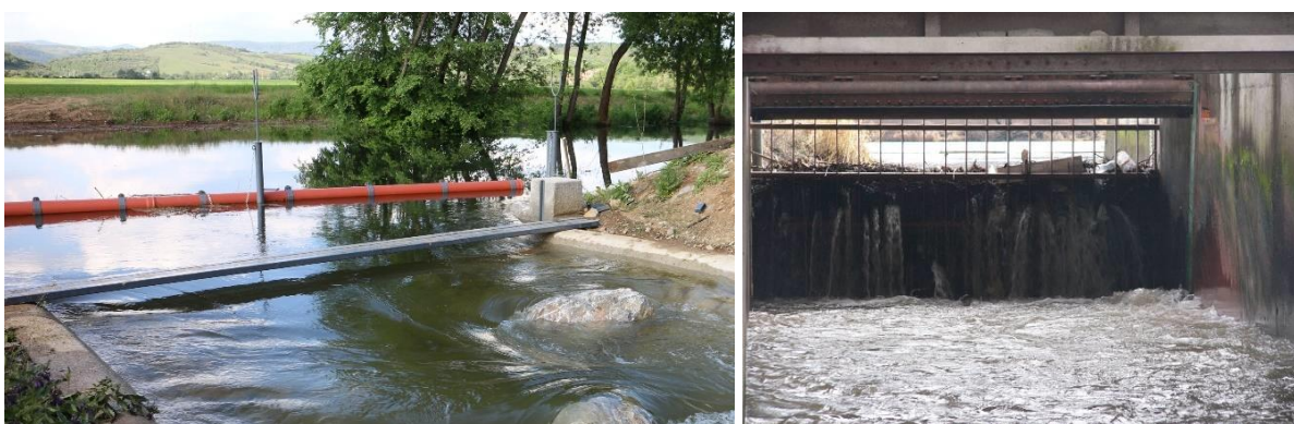
Obr. 36 vľavo: Pozitívny príklad: plávajúca norná stena predsadená šikmo pred vtok do obtokového biokoridoru (MVE Čoltovo na Slanej).
