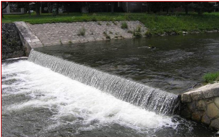
Obr. 75 Pôvodná nepriechodná migračná bariéra pred spriechodnením .
