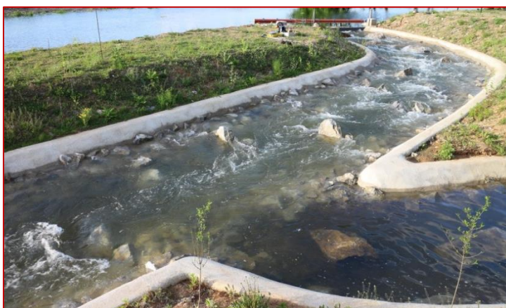
Obr. 99 Detail rýchlejšej ale neturbulentnej hĺbočiny, okrajových pomalých plytčín, oddychovej zátoky s výsadbami drevín, vzadu červená plávajúca norná stena a pevne hradený vtokový profil obmedzujúci príliš veľké prietoky – bezproblémový vtok aj koryto rybovodu.
