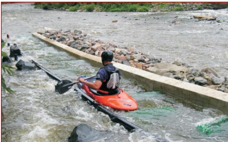
Obr. 149 Splavovanie napriamenej štetinovej rybej rampy vodnými turistami je bezproblémové . (foto R. Hassinger)
