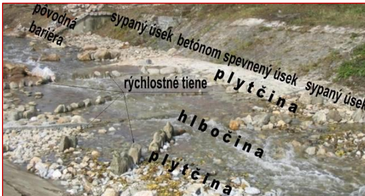
Obr. 42 Dôležité detaily vnútra koryta zrealizovaného bezprepážkového zdrsneného preliačeného sklzu.
