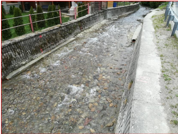
Obr. 73 Pohľad po spriechodnení . Vznikla plynulá centrálna hĺbočina aj spomalené okrajové plytčiny.
