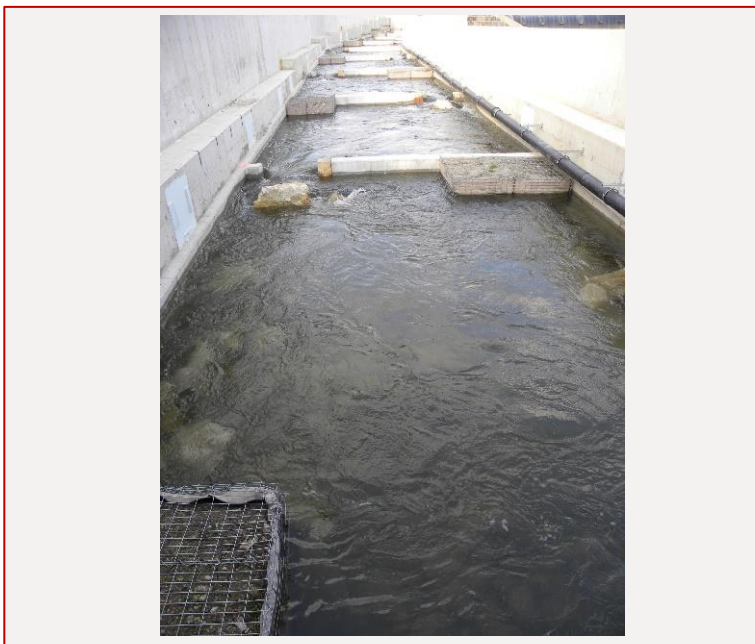
Obr.104 Pohľad na druhú a tretiu štvrtinu rybovodu, širokú až 6 m, už s vlastnosťami „oddychových“ bazénov.
