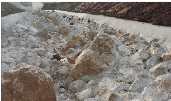
Obr. 98 Detail koridorov centrálnej hĺbočiny a okrajových plytčín, veľké úkrytové balvany medzi oboma koridormi – dno z lomového kameňa.
