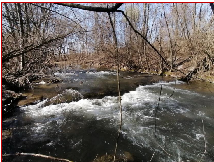
Obr. 48 Renaturalizovaný stav po vyše 15 rokoch bezobslužnej prevádzky. Pohľad na prechod medzi čiastočne odstráneným horným betónovým prahom a nebetónovým kamenným dnom pod ním, z ktorého postupne povodňové prietoky odoberajú skaly, čím sa tu začal zákonite tvoriť vodný skok v priečnom smere. Existuje predpoklad, že je problémový pre niektoré slabšie ryby v stredovej prúdnicí (tam je nutné ukladať len veľké balvany, alebo kamene podbetónovať). Na okrajoch zatiaľ ostáva priechnodné prúdenie bez skokov.
