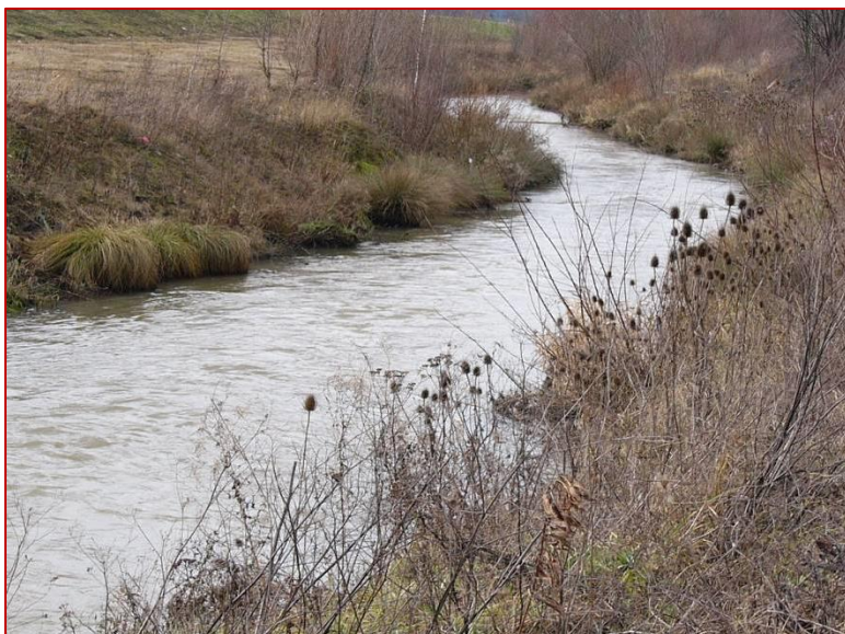
Obr. 84 Pohľad na vykovaný kanál biokoridoru vodného diela Žilina po cca 5 rokoch. Namiesto pôvodného pravobrežného terestrického biokoridoru starého Váhu bol popri novej zdrži vytvorený široký a zvlnený umelý potok biokoridoru.
