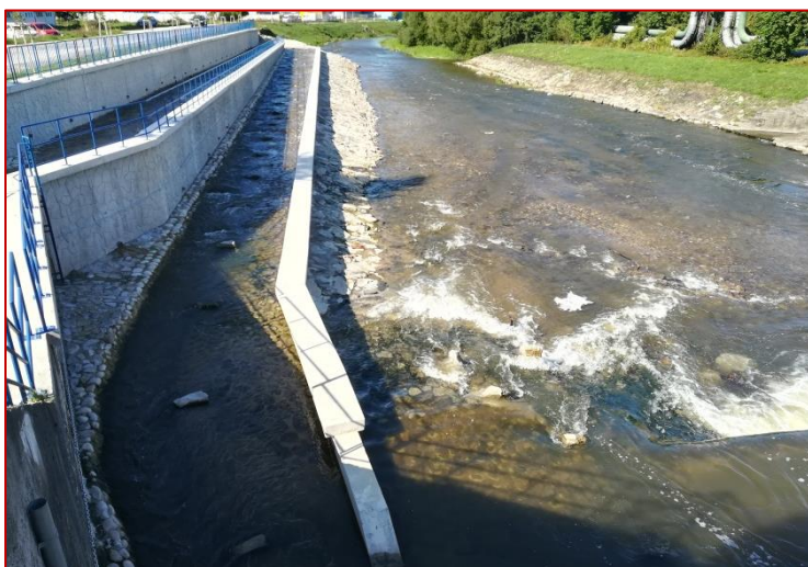
Obr. 80 Pohľad na nástupný sklz medzi riekou a vývarom, aj na dolnú a hornú rampu.
