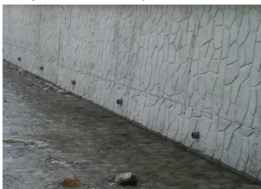
Obr. 30 a Obr. 31 Príklady matrice imitujúcej členitý kameň – pre zvislé omočené steny v rybovode.
