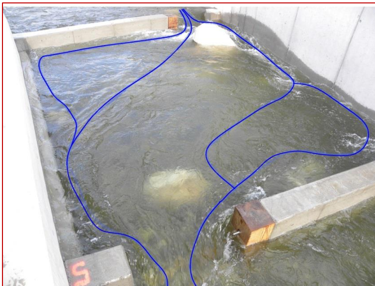
Obr. 106 Rozdelenie a upokojenie prvotných nevhodných prúdov vhodným osadením balvanov.
