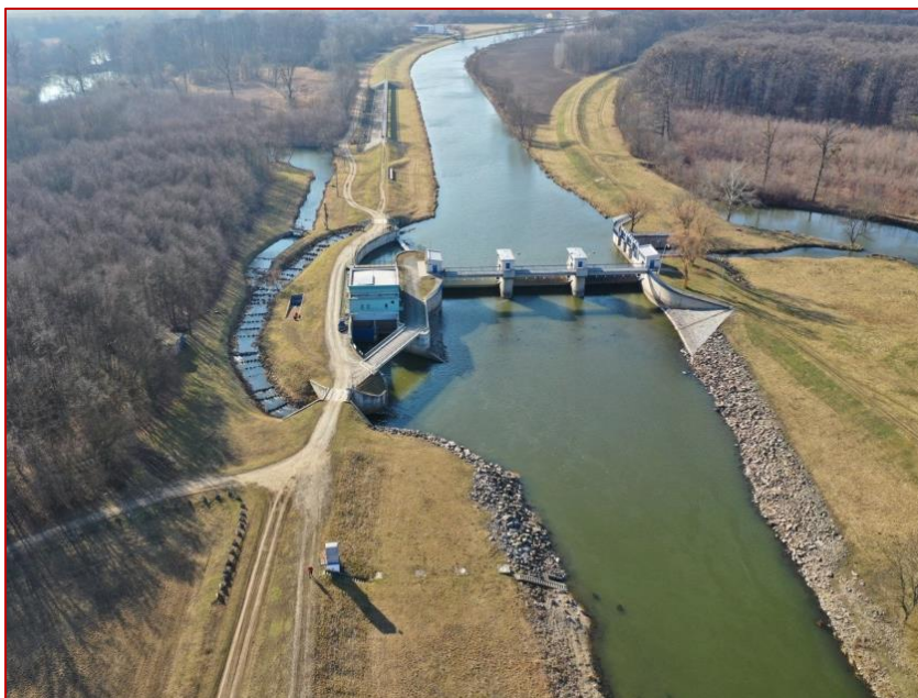
Obr. 130 Poloha obtokového bazénového rybovodu s balvanitými mnohomedzernatými prepážkami pri vodnom stupni Bulhary na rieke Dyje (Česká republika). (foto P. Brandejský)
