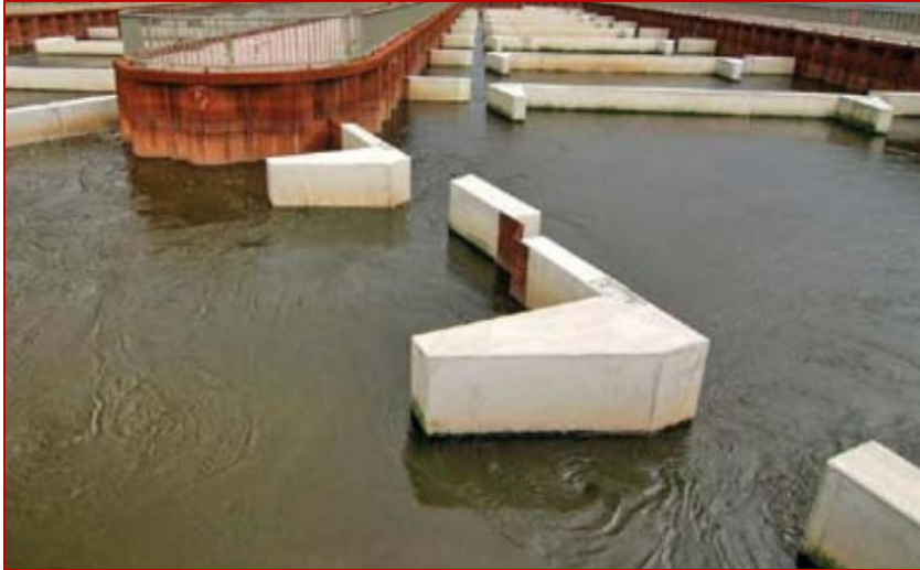
Obr. 114 Pohľad na zdvojenú štrbinu v prepážke veľkej šírky - rybovod na VD Geesthacht na Labe pri Hamburgu. (Slavík a kol. 2012)
