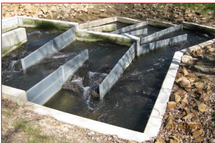
Obr. 151 Zalomený rybovod v Liebenau, na toku Diemel (Nemecko, 2010).
