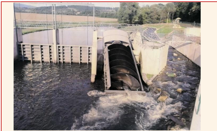
Obr. 97 Celkový pohľad na bariéru hate s Archimedovou skrutkou (fish-friendly turbína) a s miernym zrýchleným prúdením na vstupe do rybovodu pri priemernom prietoku (pre malé ryby bola pri týchto prietokoch priechodná ľavostranná plytčina).
