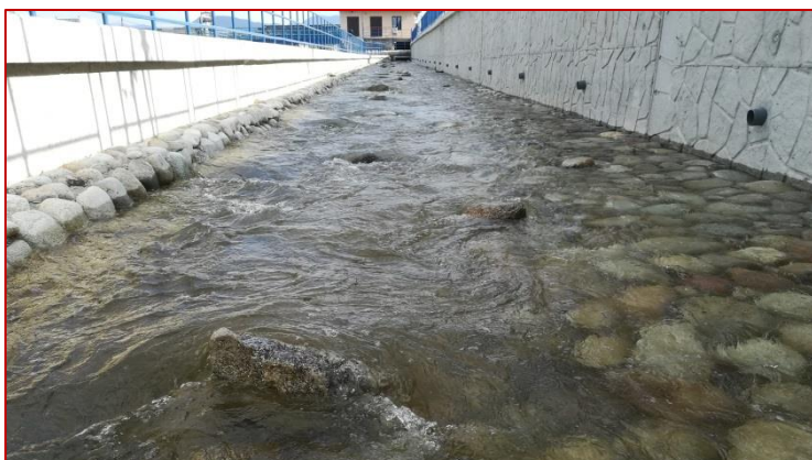
Obr. 81 Detail hĺbočiny a plynčiny v hornej časti rybovodu, relatívne malá členitosť/drsnosť dôsledne vyšpárovaného dna z riečnych kameňov.
