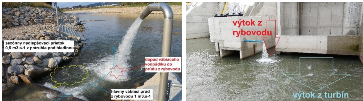
Obr. 18 vľavo: Príklad lákajúceho vodopádku v rieke horný Váh pri výtoku z obtokového bazénového biokoridoru okolo hate Podtureň-Liptovský Ján - náčrt rozmiestnenia troch vábiacich prúdov.
