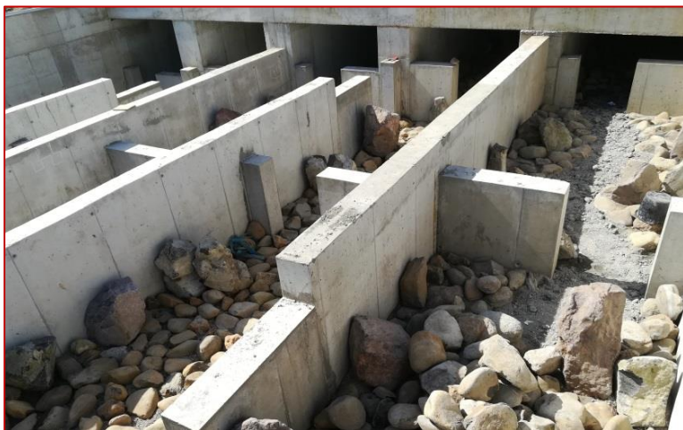
Obr. 127 Výrazne členité kamenné dno, dodatočné riešenie drsnosti stien vysokými kameňmi pri múroch.
