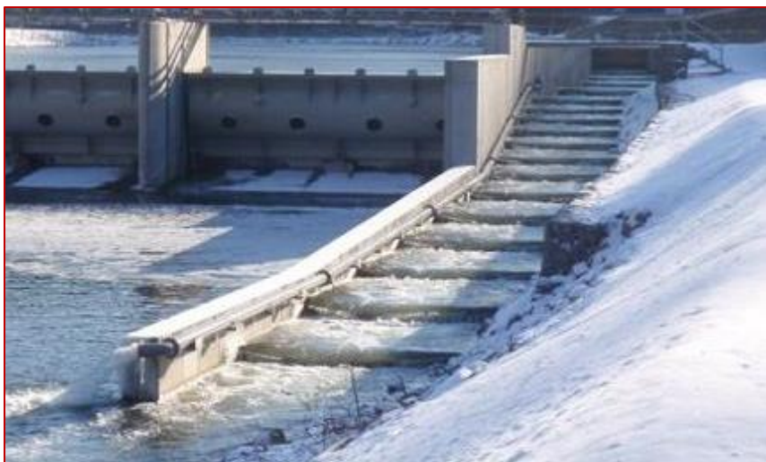
Obr. 161 Umiestnenie rybovodu na opačnom brehu ako je MVE, je nevhodné najmä na takomto toku širokom cca viac ako 40 m. Pre prilákanie rýb blúdiacich pod bariérou hate ku vstupu do rybovodu tu má slúžiť doplňujúci akusticko-vizuálny signál vodopádu vody, privádzanej potrubím. Koncentrovaný prúd vodopádu by však mal dopadať do styku prúdu Hrona a prúdu z rybovodu, aby ho ryby prilákané vodopádom zacítili na svojom tele
