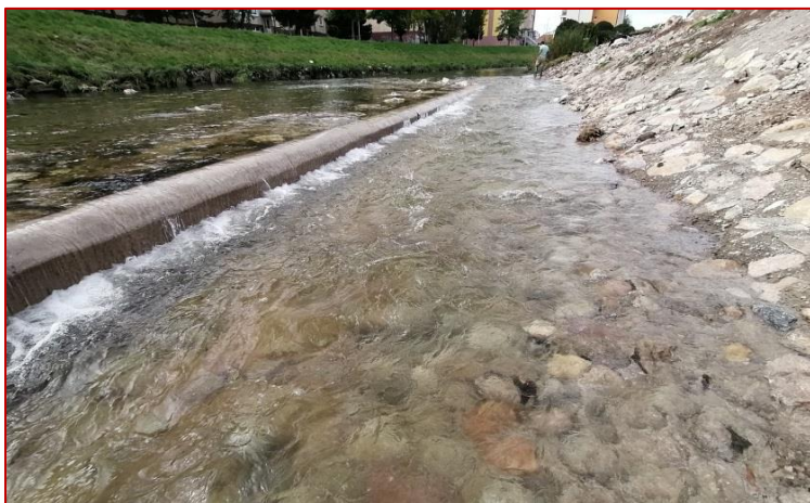
Obr. 77 Detail. Ryby majú pokojn neturbulentné a nie rýchle prúdenie v rybovode, s rýchlejšou hĺbočinou pre pstruhy a lipne a spomalenou plytčinou pre čereble a hlaváče.
