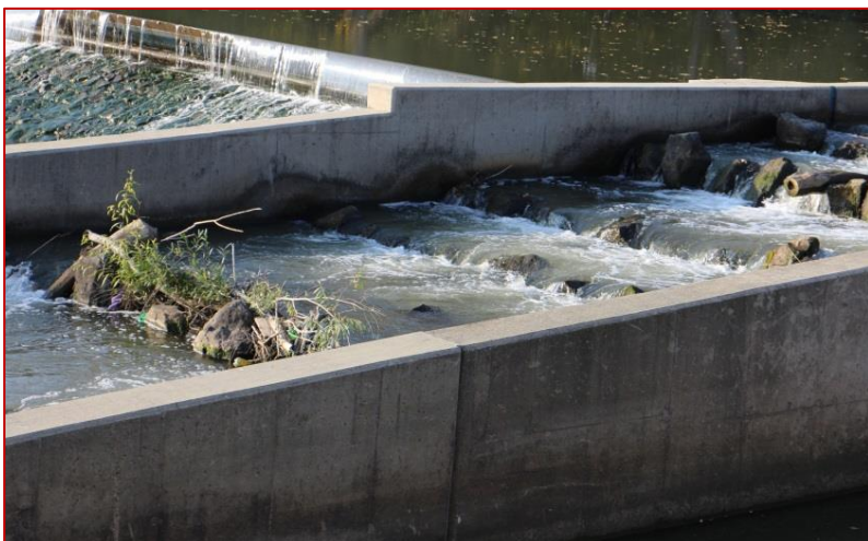
Obr. 118 Nevypočítateľné balvanité prepážky vytvárajú v hornej časti príliš veľké až vodopádové rozdiely hladín, nepriechodné pre ryby; niektoré úzke štrbiny v povodňovom koridore rieky sa zákonite musia upchať, pričom kvôli nedostupnosti je ich čistenie nemožné. MNOHOMEDZERNATÉ BALVANITÉ PREPÁŽKY sú v prípade nechráneného pretekania veľkými vodami NEVHODNÝM TYPOM!
