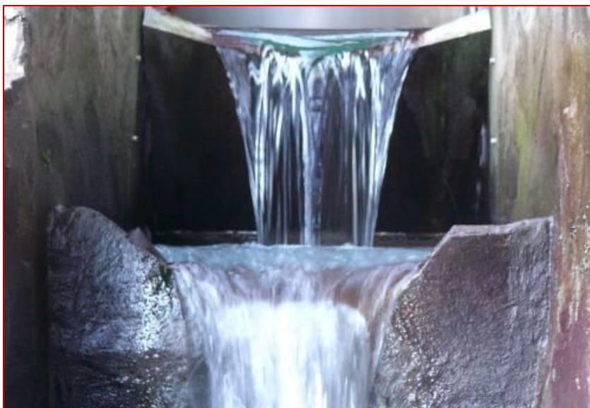
Obr. 154 Podmienkou priechodnosti pre pstruhy je prevýšenie hladín susedných komôr neprekračujúce 0,5 m (tu 0,45 m) a koncentrovaný hrubý vodný lúč minimálne 10 cm (tu 15 cm), vznikajúci vďaka výraznému trojuholníkovému preliačeniu v strede prepážky. Hĺbka vody pod prepadom musí byť aspoň 0,5 m, aby sa pstruhy mali kde „rozbehnúť“ na skok.
