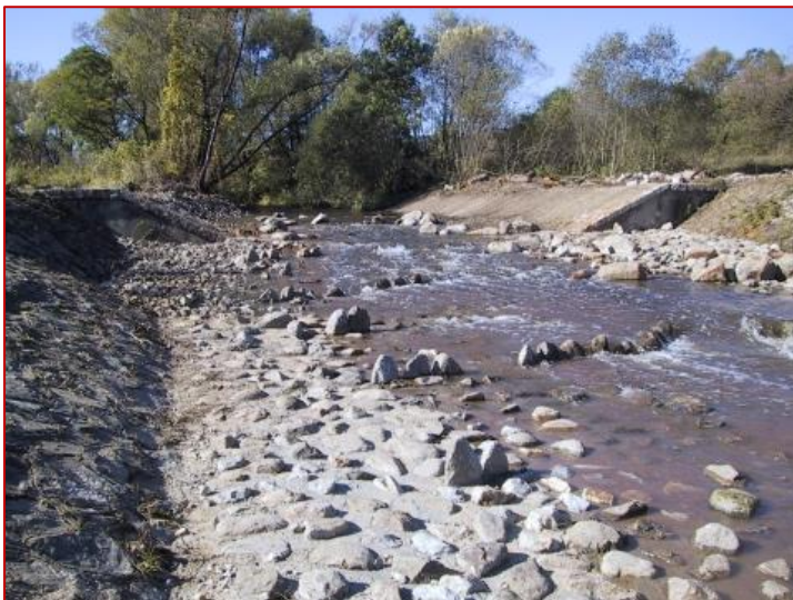
Obr. 43 Stav tesne po realizácii sklzu. Podstatou priechodnosti širokých sklzov pri extrémne malých prietokoch je trojuholníkový priečný profil.
