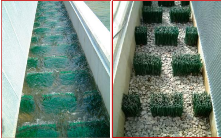
Obr. 147 Šachovnicové rozmiestnenie štrbín, nutné zatopenie štetín, nutné kamenno-štrkové dno. Takéto husté umiestnenie štetinových prepážok mimoriadne účinne spomaľuje vodu, necháva však málo priestoru väčším migrujúcim rybám , pre ktoré ide o nevhodné riešenie . (foto R. Hassinger)
