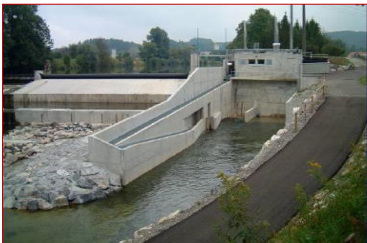
Obr. 152 a vľavo a Obr. 152 b vpravo Vodná elektrárň Au-Schönenberg na rieke Thur (Švajčiarsko), pilotný projekt s realizovaným štetinovým rybovodom (2003). Poučné je „poschodové“ technické vyriešenie rybovodu – jeho protismerné zalomenie kvôli tomu, aby výtok z neho (vstup pre ryby) nebol mnoho desiatok metrov ďaleko od bariéry, ale len niekoľko metrov pod migračnou bariérou, v hlavnom navádzacom prietoku pod výtokom z turbín. Výhodnejšie umiestnenie vstupu pre ryby a miernejší sklon rybovodu sú pre ryby dôležitejšie ako neprirodzené pôsobiace zvislé betónové brehy a technicky zložité riešenie, aj ako čiastočné lokálne prekrytie časti trasy. (Úsek s úplnou tmou by však bol nevhodný pre denné migrácie rýb).
