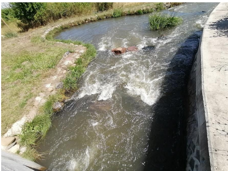
Obr. 128 Búrlivejší výtok pri prechode z 90 cm hlbokých bazénov vo vtokovom úseku rybovodu na 70 cm hlboký prúd v bystrinnom úseku biokoridoru. Pôvodne búrlivé prúdenie s veľkým skokom hladiny bolo potrebné dodatočne utlmiť (zavzduť balvanitými prepážkami). Pre menej zdatné ryby sa tak vytvorila upokojená plynulá plytčina popri brehu .
