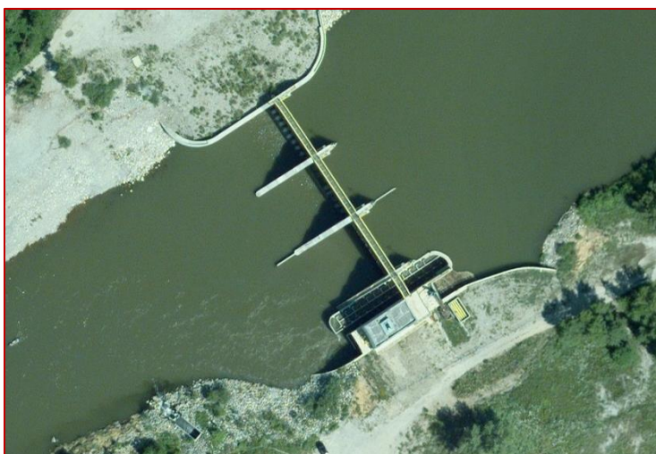
Obr. 111 Poloha vnútrokorytového rampového rybovodu Trenčianske Biskupice v rozšírenom pilieri hate. (zdroj ZBGIS)
