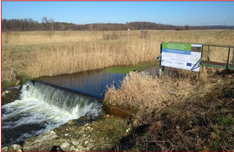
Obr. 66 Pôvodná nepriechodná migračná bariéra pred spriechodnením, pozdĺž vzdutia vyvinuté vysokosteblové brehové porasty.
