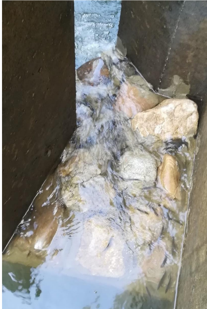
Obr. 25 b Ukážka pomeru veľkosti tiel malých rýb (dĺžky 4-5 cm, výšky do 1 cm – na fotke šedé pružky) a oveľa väčšej veľkosti migračných škár medzi skalami v prírode podobnom členitom dne (pohľad do štrbiny vypúšťaného bazénového rybovodu, normálna hĺbka vody v štrbine min. 70 cm).
