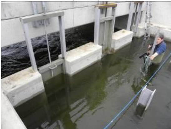
Obr. 212 Meranie prietoku na vtoku do rybovodu.
