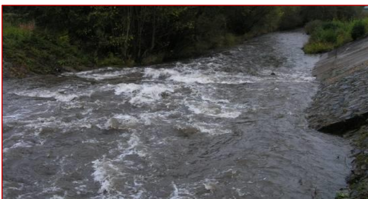
Obr. 46 Aj počas búrlivých prietokov majú ryby a mihule na okrajoch preliačeného sklzu dostatočne pokojné plytčiny.
