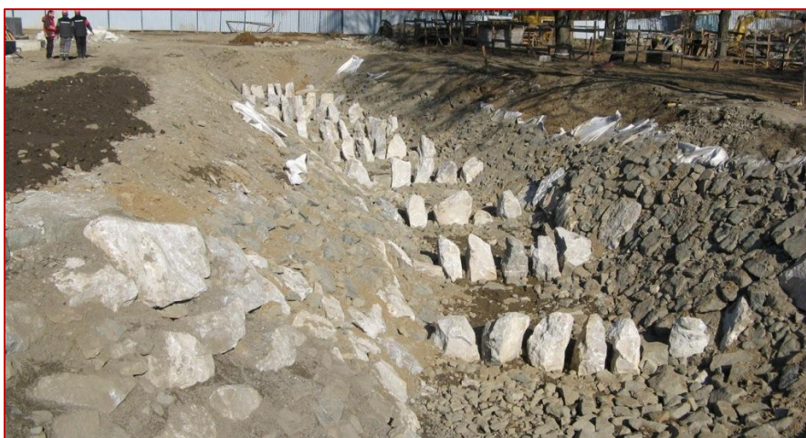
Obr. 131 Pohľad na rybovod počas výstavby (foto J. Kašpar).
