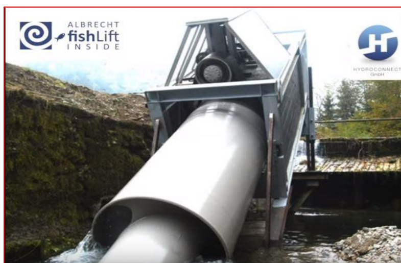
Obr. 165 Zdvojená Archimedova skrutka umiestnená na okraji migračnej bariéry (Hydro-Connect GmbH)
