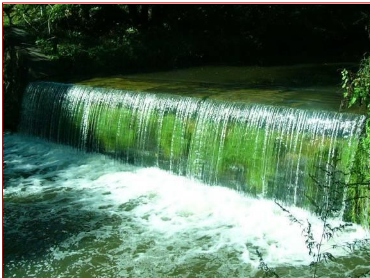
Obr. 56 Pôvodná nepriečhodná migračná bariéra pred spriechodnením – vodopádový priečny stupeň s prevýšením 1,7 m.
