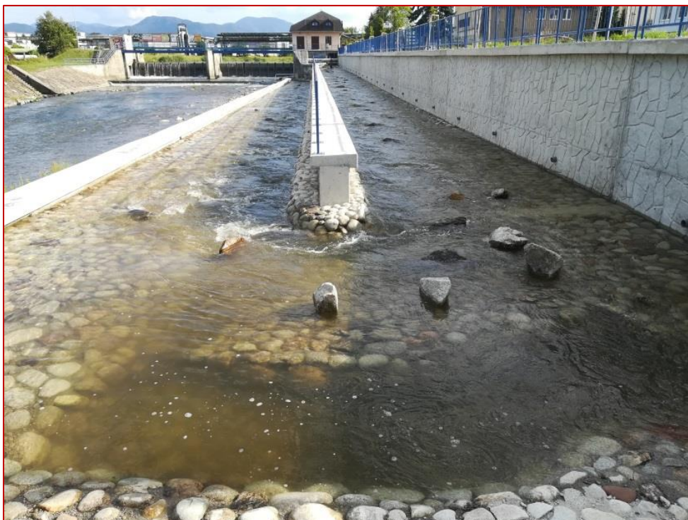
Obr. 80 Pohľad na nástupný sklz medzi riekou a vývarom, aj na dolnú a hornú rampu.
