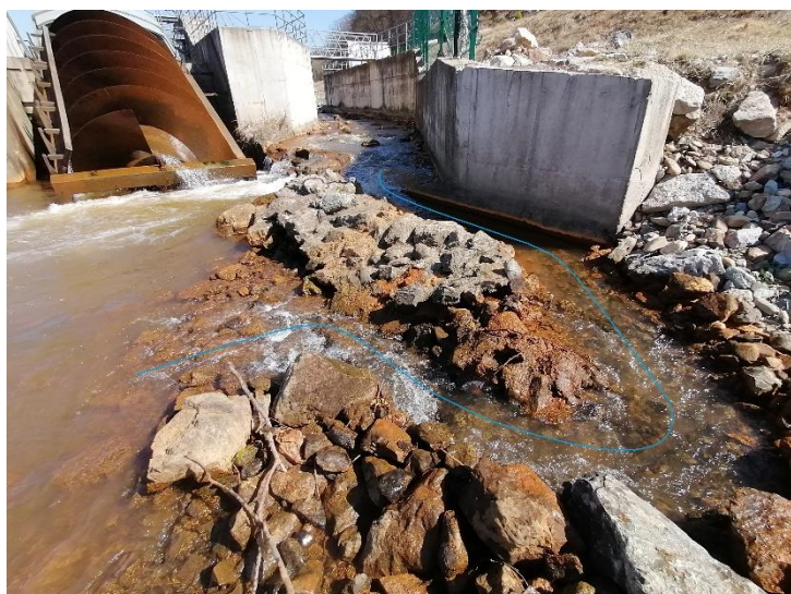
Obr. 100 Pri podpriemerných prietokoch Slanej sa ústie rybovodu ocitalo vysoko a prepadalo do rieky prepadom priechodným len pre zdatné ryby. Pre menšie málo zdatné ryby sa dodatočne vytvorilo predĺžené oveľa pokojnejšie plytké rameno rybovodu (naznačené modrou čiarou).
