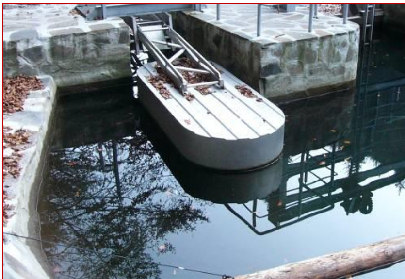
Obr. 153 Stabilne veľký vtok vody do rybovodu automaticky reguluje veľký oválny plavák . Vpredu plávajúce hradenie proti vniknutiu plavenín.
