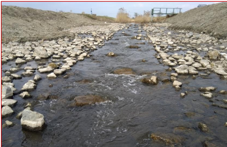
Obr. 67 Pohľad na nový celokorytový sklz s vloženou centrálnou kynetou pre nižšie prietoky (stav pri bežnom prietoku).
