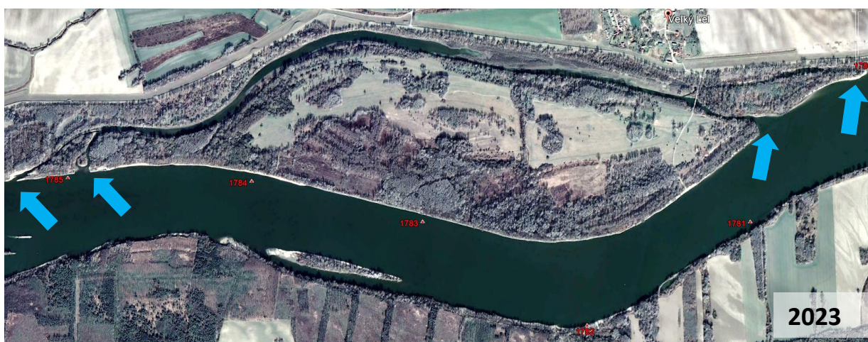
Obr. D.11 Velkolélský ostrov – sprietočnené dve ramená na vtoku a dve vetvy výtoku, vybudovanie mosta cez rameno – odstránenie bariéry – realizovala BROZ
