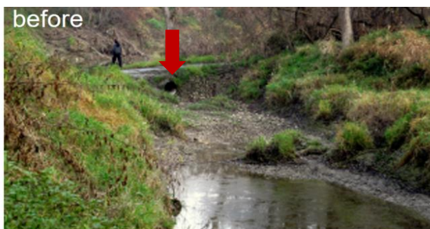
Obr. D.4 Rúrový priepust na hlavnom devínskom ramene vytváral bariéru - stav 2010
