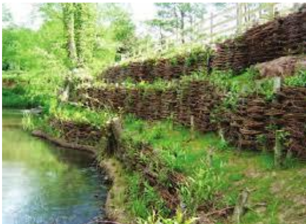
Obr. 10.14 Viacrádové zápletové vřbové plôtiky na zabezpečenie stability brehov
