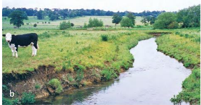
Obr.C.2 Vytvorenie nového meandrujúceho koryta, ktoré zároveň umožňuje častejšie zaplavovanie inundačného územia na rieke Cole (UK), a) počas výstavby, b) 2 roky po realizácii (RRC)
