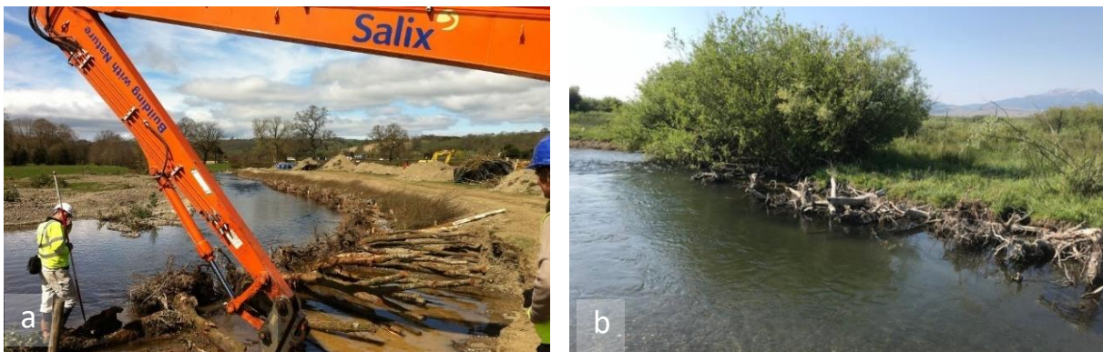
Obr.5.17 Revitalizácia brehov – stabilizácia brehov pomocou veľkých drevených prvkov ukladaných do päty svahu konkávneho oblúku (a), stav brehu s veľkými drevenými prvkami osadenými po určitej dobe (b)
