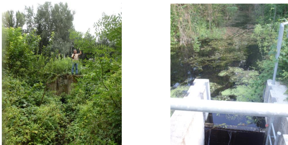
Obr. 12.9 Vybudovanie zhybky na Čiližskom potoku s melioračným kanálom Vrbina-Holiare – sprietočnenie v lete vyschnutého úseku (prvý obrázok), zmena terestrickej vegetácie na mokradňovú a vodnú vegetáciu (druhý obrázok).
