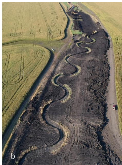
Obr.C.6 Príklad revitalizácie napriamenej rieky Cole (UK) premeandrováním v obmedzenom poľnohospodársky využívanom priestore (a) schéma premeandrovania - pôdorys, (b) pohľad na premeandrované koryto
