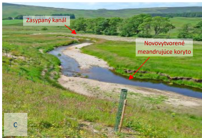
Obr.C.5 Schéma revitalizácie rieky Highland Water (a); vytvorené koryto rieky vzniklo vyťažením sedimentov z pôvodného meandrujúceho toku – 09/2012, (b); pohľad na obnovené koryto po roku – 07/2013, pôsobenie procesov transportu a sedimentácie umožnilo formovanie koryta a korytových makro-útvárov– lavíc. (RRC, 2019)
