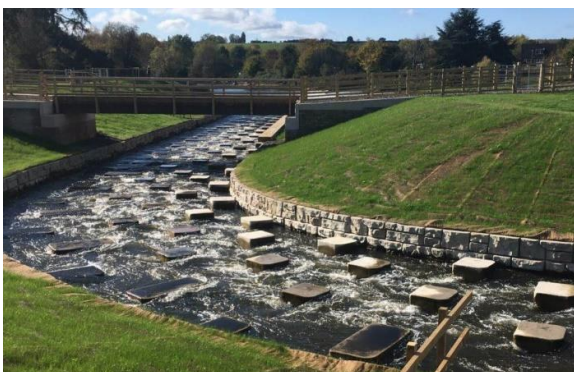
Technický rybovod na rieke Severin (UK)
