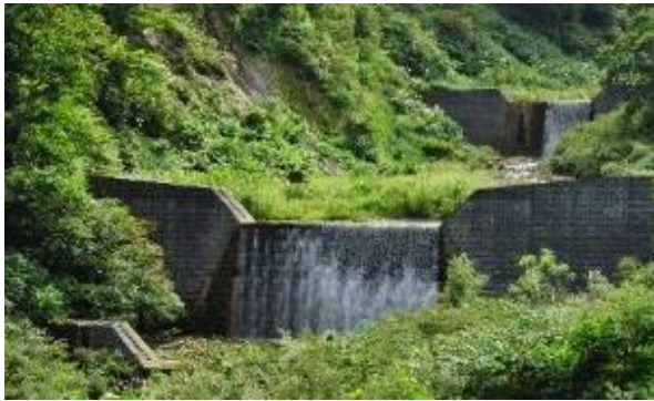
a) prehrádzky na stabilizáciu sklonu
