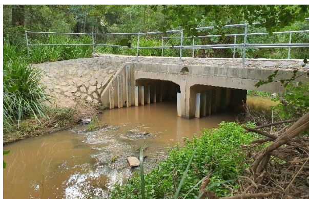
Odstránenie bariéry old Norco na rieke Richmond Casino, New South Wales
