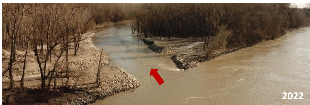
Obr. D.1 Klúčovecké rameno – sprietočnené v roku 2019
