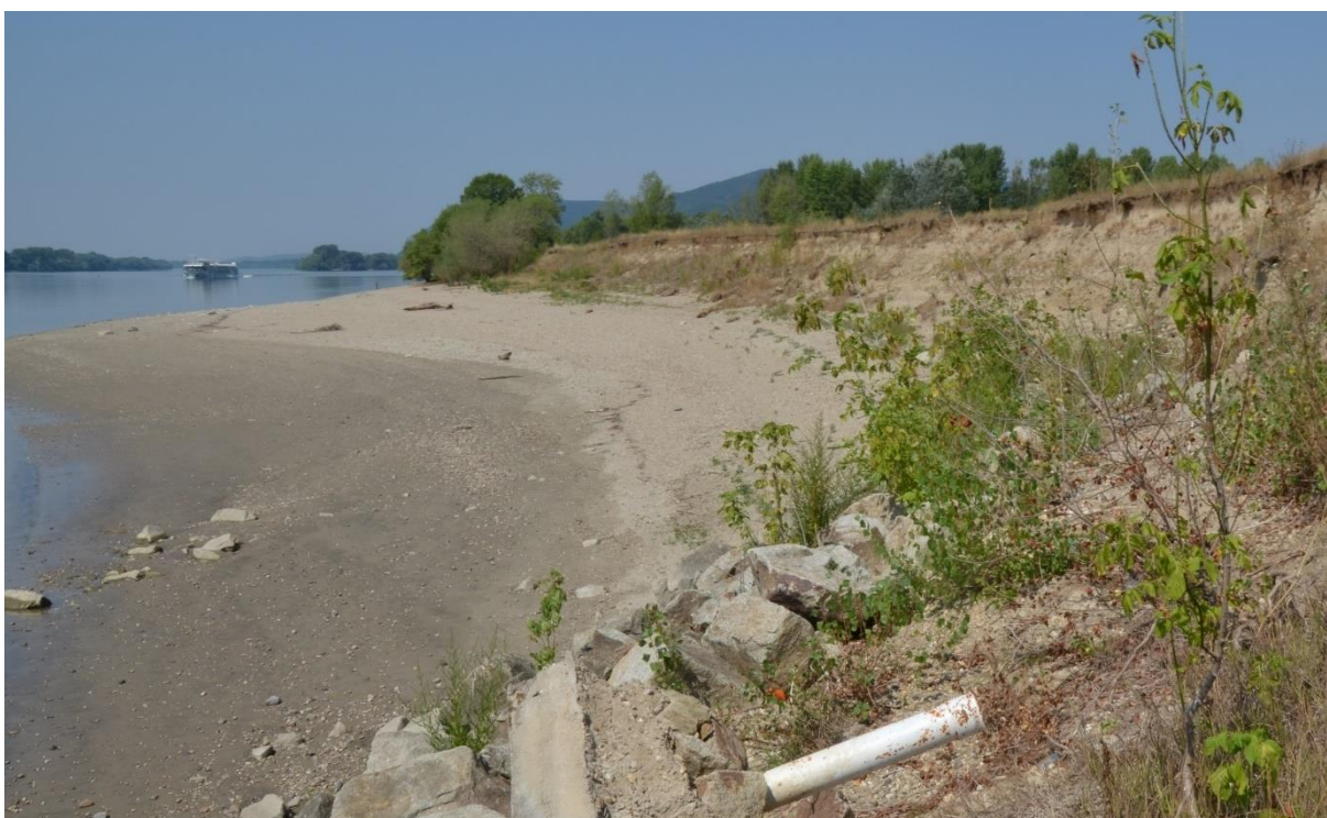
Obr. D.16 Chľaba - obnova laterálnej konektivity: odstránenie brehového opevnenia a sprírodnenie brehov, foto VÚVH 2015
