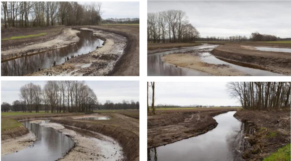
Obr.12.1 Pohľad na rieku krátko po realizácii revitalizačných opatrení – premeandrovanie napriameného toku v poľnohospodársky využívanej krajine (Holandsko)
