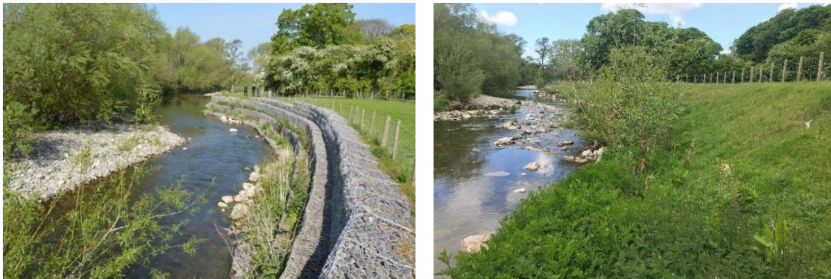
Obr. 10.16 Použitie drôtokamenných košov (vľavo) a kamenných matracov Salix (vpravo) – bioinžinierske riešenie stability brehov v prípade ak treba breh zabezpečiť proti nadmernej erózii
