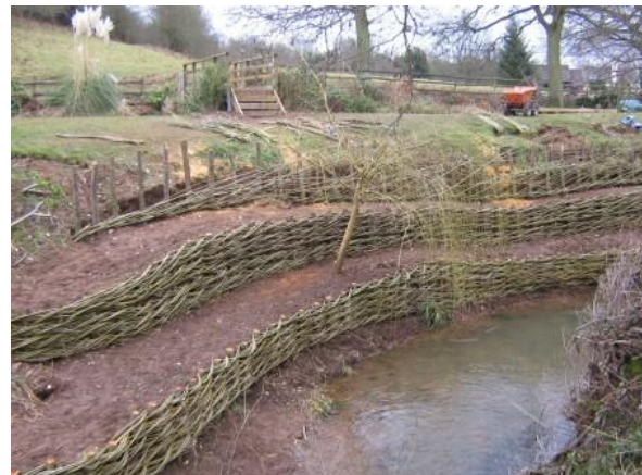
Obr. 10.14 Viacrádové zápletové vřbové plôtiky na zabezpečenie stability brehov
