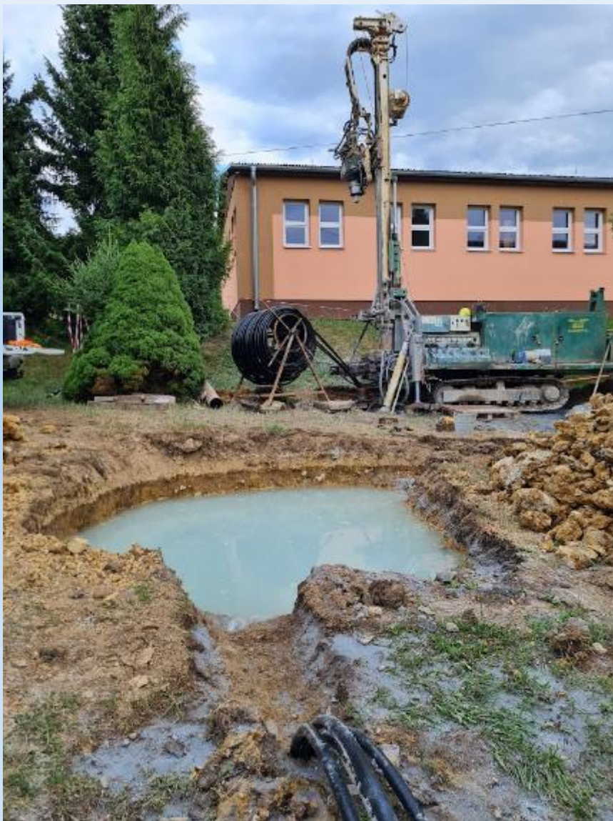
VŘTANIE VALIVÝM DLÁTOM S VODNÝM VÝPLACHOM
