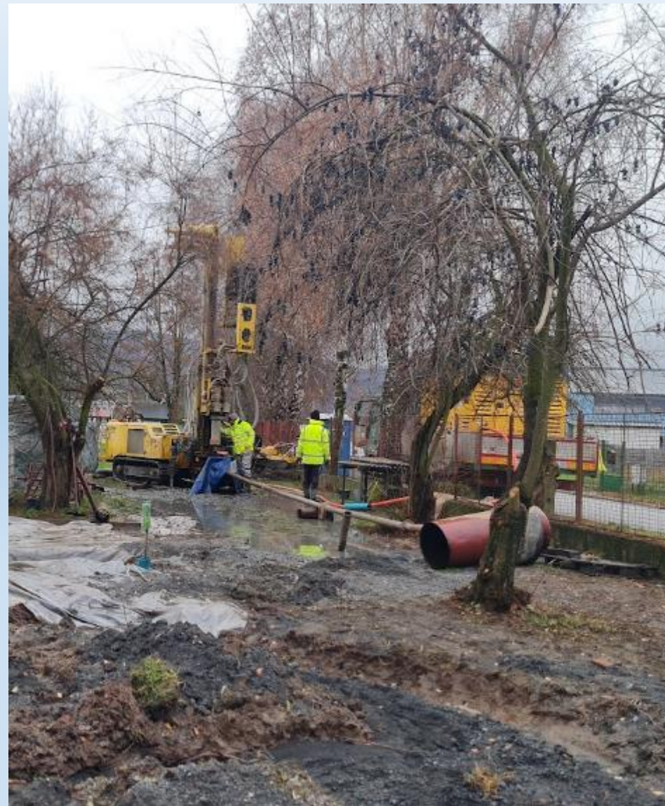
VŘTANIE PONORNÝM KLADIVOM S VZDUCHOVÝM „VÝPLACHOM“
