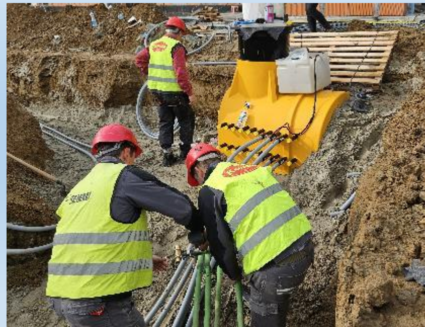
Spájanie horizontálnych potrubí z vrto v do zlučovacej šachty
