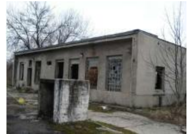
SK/EZ/LV/440 Pohr. Ruskov – mazutové hospodárstvo bývalého cukrovaru
