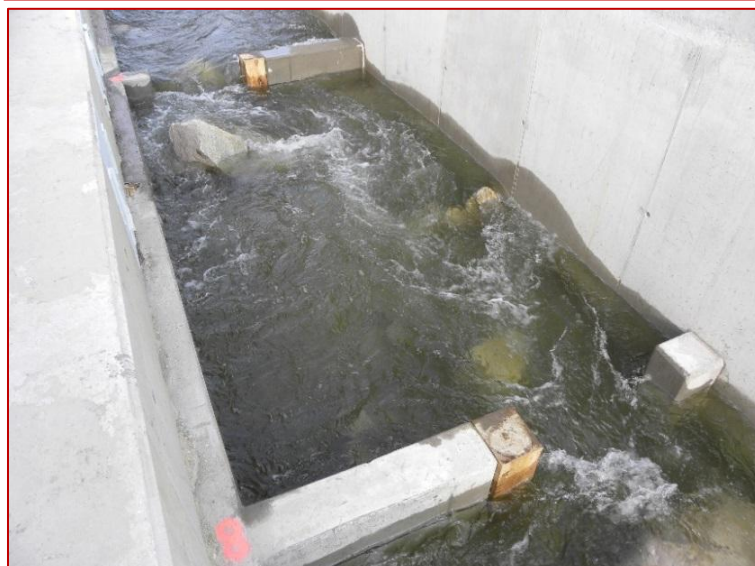
Obr.105 Pohľad na najužšie bazény v hornej a dolnej časti rybovodu, široké len 3 m, ale s dostatočne upokojenými vodnými priestormi pre oddych rýb s rýchlosťami menšími ako 1 \text{ m} \cdot \text{s}^{-1} . (Rýchlosti v tomto prietokovom otvore boli 1,46 \text{ m} \cdot \text{s}^{-1} pri hladine, 1,37 \text{ m} \cdot \text{s}^{-1} v strede a 1,0 \text{ m} \cdot \text{s}^{-1} nad dnom, teda výrazne pod limit 1,5 \text{ m} \cdot \text{s}^{-1} ).
