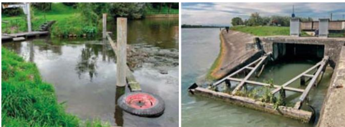
Obr. 34 vľavo (VD Langwedel tok Weser) a Obr. 35 vpravo (VD Kembs tok Rýn) Dva príklady prijateľného hradenia nornej steny dostatočne predsadenej pred vtokový otvor (Slavík a kol. 2012).
