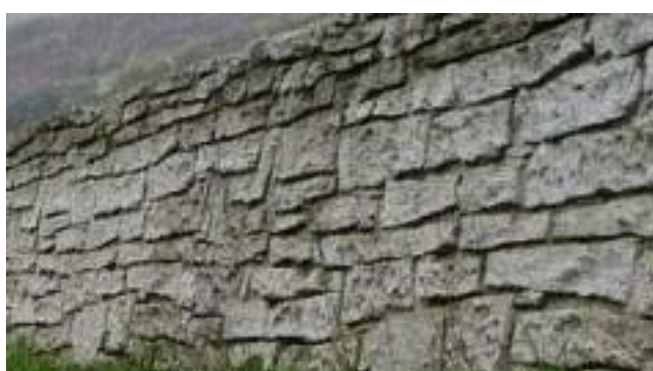
Obr. 30 a Obr. 31 Príklady matrice imitujúcej členitý kameň – pre zvislé omočené steny v rybovode.
