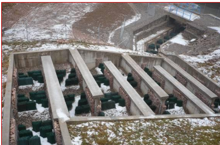
Obr. 150 Mimoriadne účinné spomaľovanie bystrinného prúdenia štetinami, ako aj opakované zalomenie trasy, umožňuje prekonanie veľkých prevýšení na malom priestore . Na tomto obrázku je rybovod pri nesprievádzkovej MVE Ružbašská Miľava na Poprade v rkm 73,7 (2013). (foto M. Macková)
