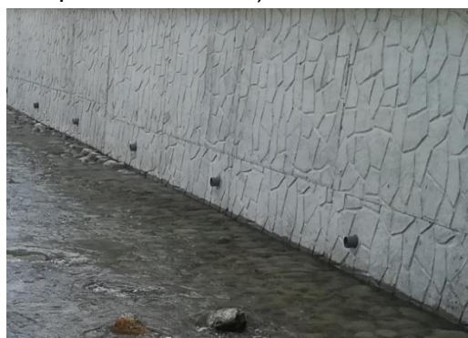
Obr. 30 a Obr. 31 Príklady matrice imitujúcej členitý kameň – pre zvislé omočené steny v rybovode.
