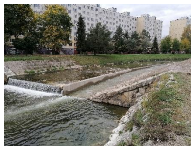
Typ 3: Vnútrokorytová bystrinná rampa.
