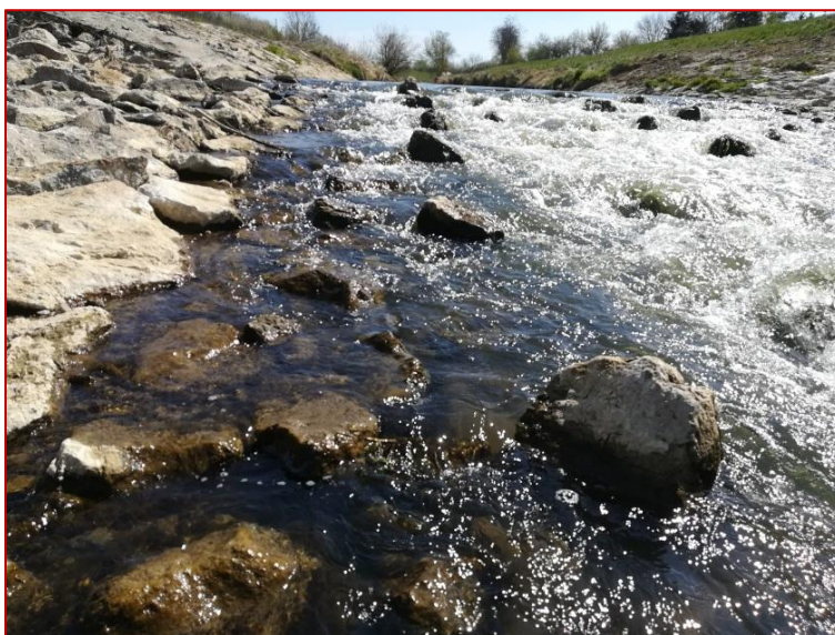
Obr. 70 Detail výrazne pomalej plytšej príbrežnej prúdnice pre slabšie menšie ryby (na okraji rýchlej hlbkej centrálnej prúdnice pre zdatné veľké ryby).
