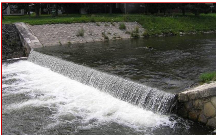
Obr. 75 Pôvodná nepriechodná migračná bariéra pred spriechnením .
