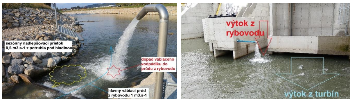
Obr. 18 vľavo: Príklad lákajúceho vodopádika v rieke horný Váh pri výtoku z obtokového bazénového biokoridoru okolo hate Podtureň-Liptovský Ján - náčrt rozmiestnenia troch vábiacich prúdov.
