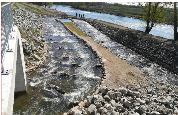
Obr. 94 Pohľad na dolný úsek bystriny pod zúženým a pôvodne aj zrýchleným kruhovým výtokom cez protipovodňovú hrádzu. Tento úsek musel byť kvôli spomaleniu zúženého prúdu mierne pozavzdúvaný prerušovanými kamennými prehrádzkami.
