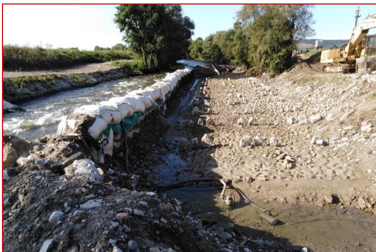
Obr. 64 Záber z výstavby ukazuje dno z riečnych kameňov aj rozmiestnenie oddychových balvanov. Vozduchu pôvodná nepriechodná migračná bariéra pred spriechodnením – vodopádový riečny stupeň s prevýšením hladín cca 0,8 m.
