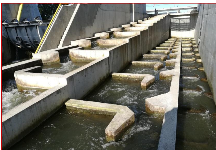
Obr. 112 Tri ramená stúpajúcich veľkoobjemových bazénov medzi MVE (vpravo) a haťou (vľavo). Hydraulicky optimálne riešenie prúdenia vo veľkokomorovom štrbinovom rybovode (pozri aj obrázok dole). Pod každou nepriepustnou prepážkou vznikajú dostatočne rozsiahle zóny s upokojenou vodou pre oddych rýb. Keďže prúd je tu umelo vychyľovaný, priechodové otvory je tu vhodnejšie radiť nie striedavo, ale priamo za sebou.
