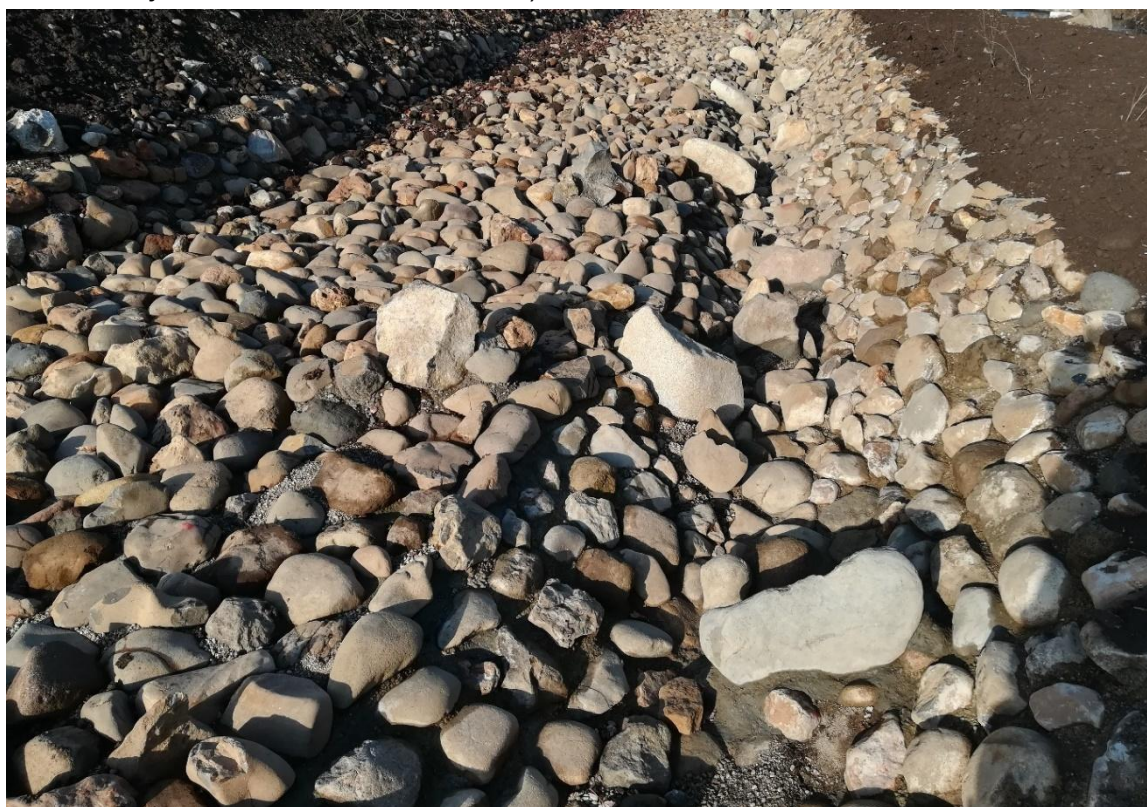
Obr. 27 Príklad silne členitého dna z riečnych kameňov kladených na vzájomný dotyk (do podkladového betónu), s veľkými oddychovými balvanmi vo vymodelovanej hĺbočine aj v širokej pomalej plytčine.
