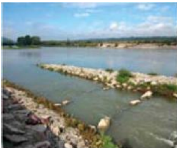
Obr. 20 vľavo (VD Ruppertswill tok Aare) a Obr. 21 vpravo (VD Dogern tok Rýn) Negatívne príklady výtoku z rybovodu málo atraktívneho pre vstup rýb (dekonzekcia - rozptýlenie vábiaceho prúdu ešte pred hlavným tokom, ktorým migrujú ryby) (Slavík a kol. 2012).
