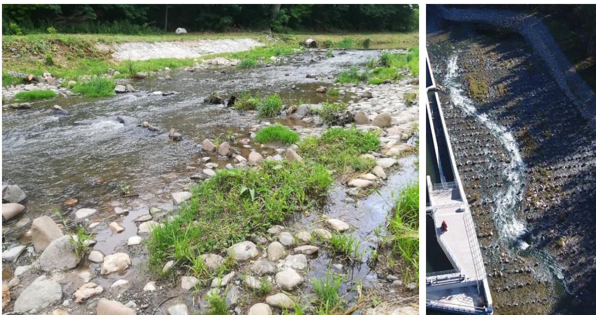
Obr. 26 b (vľavo) Miskovitě priečne preliačenie koryta s centrálnou hĺbočinou, bočnými plytčinami, prechádzajúcimi do okrajových vnútrokorytových kamenno-štrkových lavíc.
