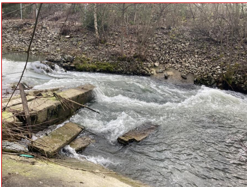
Obr. 89 Prah v telese biokoridoru ktorý je viditeľne nepriechodný pre akékoľvek ryby (foto M. Kubala).
