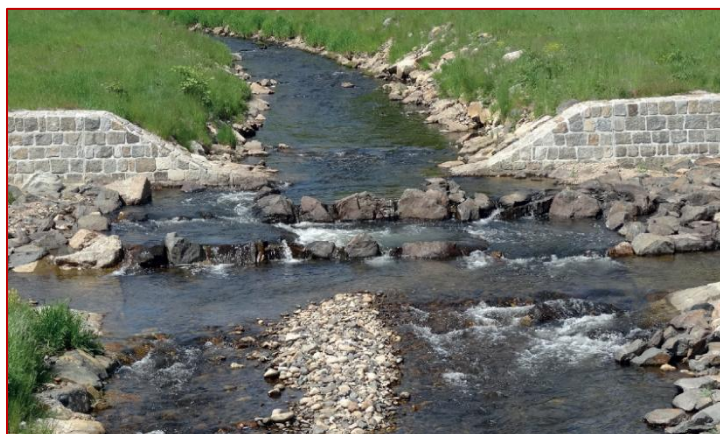
Obr. 101 Príklad spätného zatopenia (zavzdutia a spriechodnenia) stupňa pomocou niekoľkých celokorytových prepážok, prerušených priechodovou štrbinou (Musil, Marek a Barankiewicz 2020).
