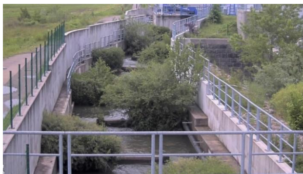
Obr. 33 a vľavo Príklad vegetačných zemných boxov v projekte (rybovod Zvolen) a Obr. 33 b vpravo Realizované zazemnené boxy v bazénovom rybovode Šalková po 6 rokoch prevádzky.
