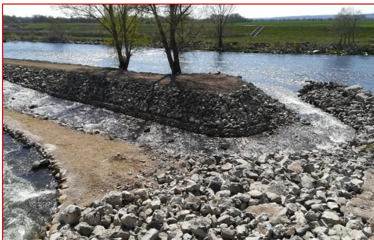
Obr. 92 Pohľad na dolný vstup rýb.
