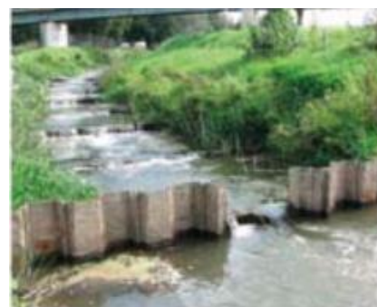
Obr. 22 vľavo (schéma vyústenia rybovodu hať Martin tok Turiec) a Obr. 23 vpravo (VD Petershagen tok Weser) Príklady potrebnej koncentrácie vábiaceho prúdu priamo na výtoku z rybovodu do hlavného toku, ktorým migrujú ryby: vľavo zúženie výtoku z rybovodu zo 4 m na 2,6 m, vpravo obrázok z metodiky Slavík a kol. 2012, kde však potrebné zúženie odporúčame vyriešiť prírode bližším spôsobom – napr. prerušeným radom balvanov alebo zúžením brehov rybovodu v ústí do rieky.
