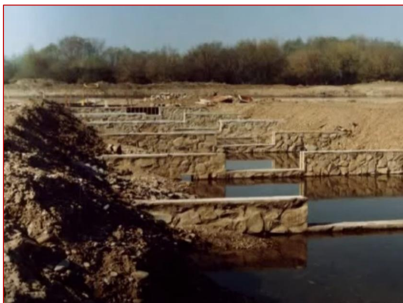
Obr. 119 Kamenno-betónové prepážky a oddelené okolie počas výstavby rybovodu.
