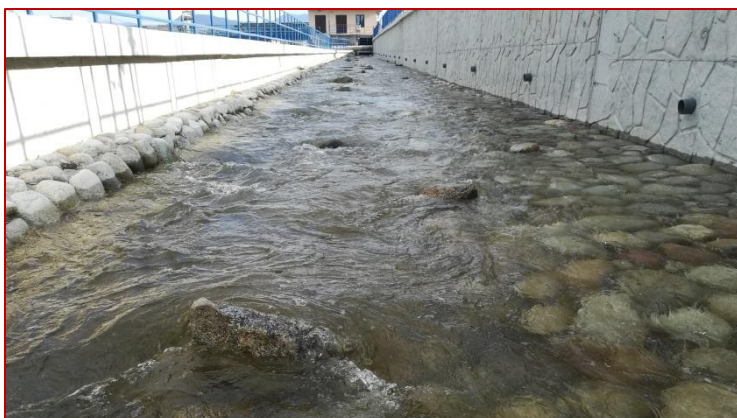
Obr. 81 Detail hlbôčiny a plytčiny v hornej časti rybovodu, relatívne malá členitosť/drsnosť dôsledne vyšpárovaného dna z riečnych kameňov.
