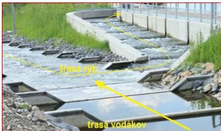
Obr. 124 Pohľad na vtok do rybovodu pre migráciu rýb (vpravo) a na vjazd pre vodákov (vpredu).
