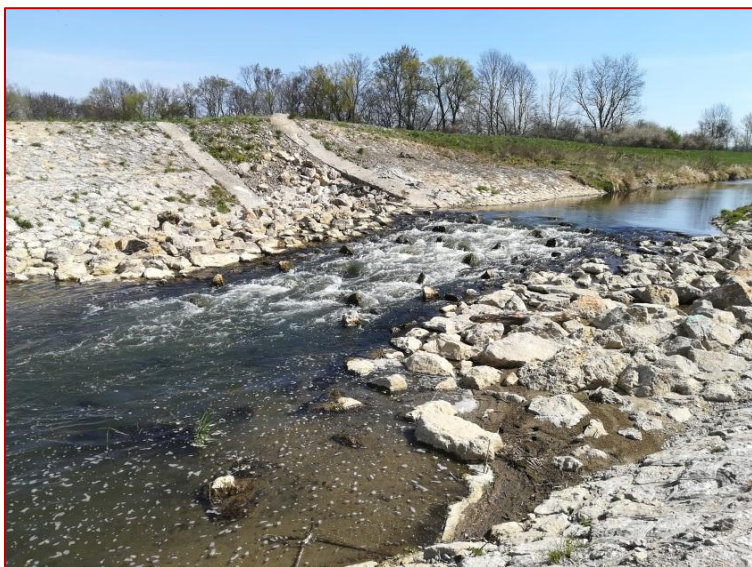
Obr. 69 Pohľad na nový celokorytový sklz s mierne preliačeným trojuholníkovým priečnym rezom, do ktorého je vložená hlbšia centrálna kyneta s kapacitou pre podpriemerné prietoky pod Q_{180} (stav pri bežnom prietoku). Pohľad z ľavého brehu.
