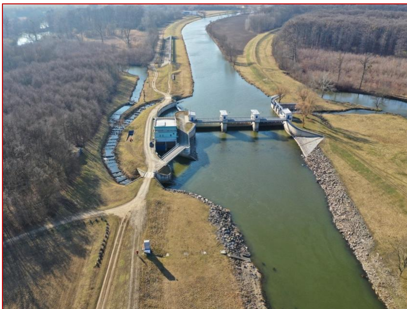
Obr. 130 Poloha obtokového bazénového rybovodu s balvanitými mnohomedzernatými prepážkami pri vodnom stupni Bulhary na rieke Dyje (Česká republika). (foto P. Brandejský)
