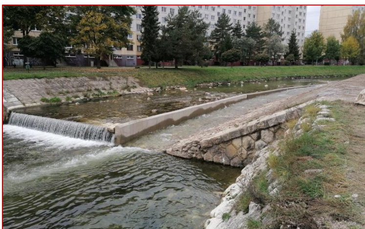
Obr. 76 Celkový pohľad na zachovanú hĺbočinu vývaru, na čiastočné odstránenie štvrtiny bariéry a jej nahradenie novovytvorenou vnútrokorytovou bystrinnou rampou.
