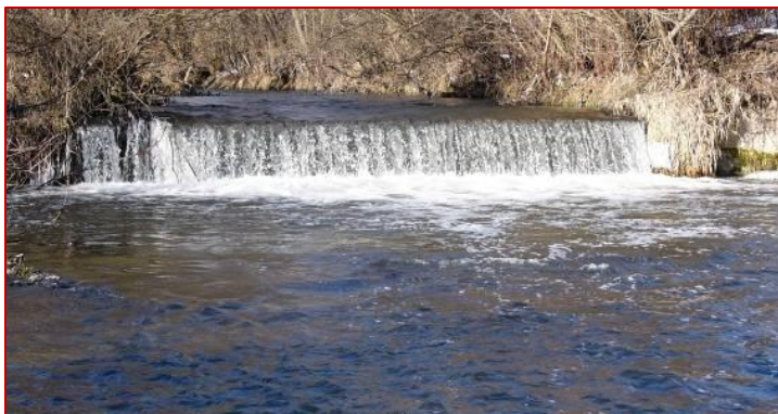
Obr. 41 Pôvodná nepriechodná migračná bariéra Muránka I pred spriechnením – vodopádový riečny stupeň s prevýšením hladín 1 m.
