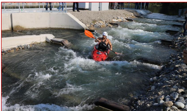
Obr. 123 Riešenie splavnenia rybovodu: Normálne priteká zo zdrže do rybovodu (zľava) bežný prietok. V prípade priplávania rekreačného člnku zo zdrže (vpravo vzadu) si člnkár úderom vesla do zariadenia pustí do strmého pripájacieho vodáckeho úseku (vpravo nad sútokom) výrazný prídavný prietok, ktorý mu vydrží po dobu splavu rybovodu.
