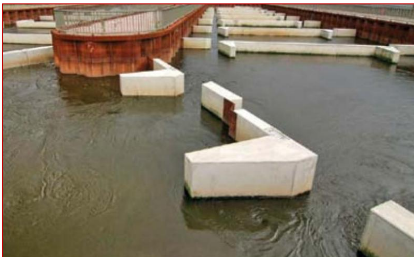
Obr. 114 Pohľad na zdvojenú štrbinu v prepážke veľkej šírky - rybovod na VD Geesthacht na Labe pri Hamburgu. (Slavík a kol. 2012)
