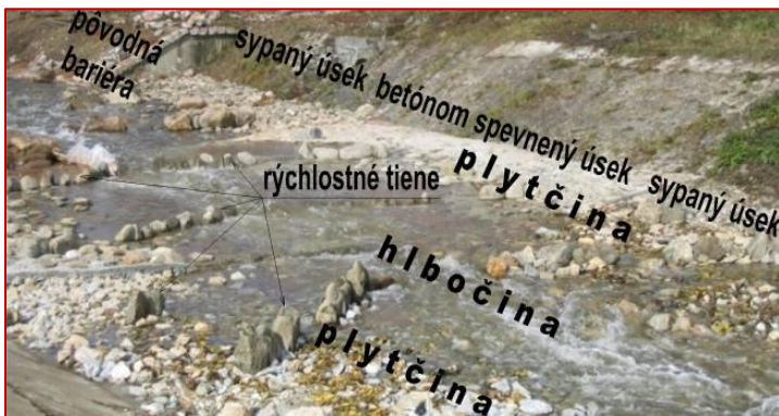
Obr. 42 Dôležité detaily vnútra koryta zrealizovaného bezprepážkového zdrsneného preliačeného sklzu.
